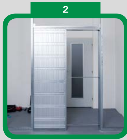
2 Usazení pouzdra do spodního profilu SDK
