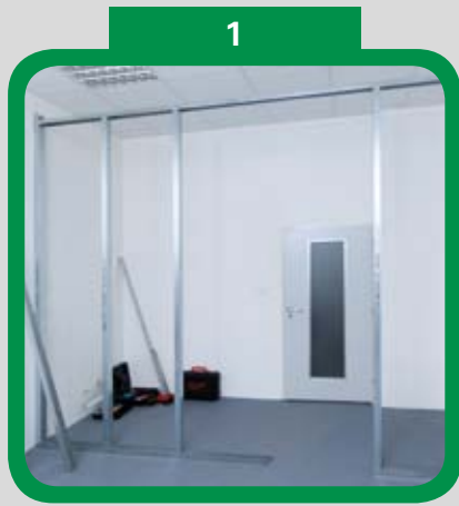
1 Příprava profilů SDK pro usazení pouzdra
