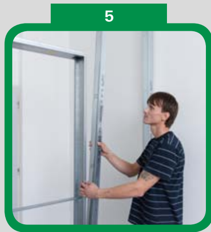
5 Montáž protilehlé strany SDK konstrukce
